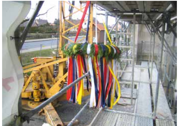
Am 28.2.2020 konnte Richtfest gefeiert werden. © Herbert Holz
