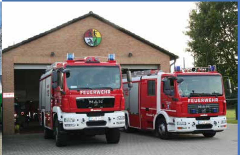
Feuerwehrhaus in Weyhausen. © Ortsfeuerwehr Weyhausen
